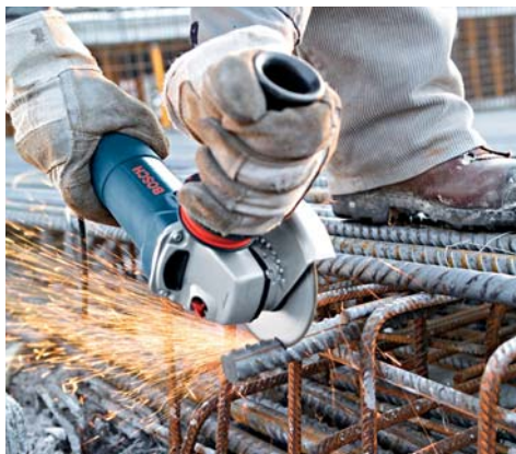
13.2. Использование УШМ для отрезания арматуры
