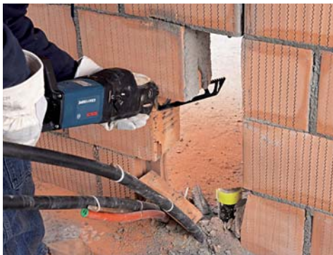
10.1. Использование сабельной пилы для пиления в кирпичной кладке
