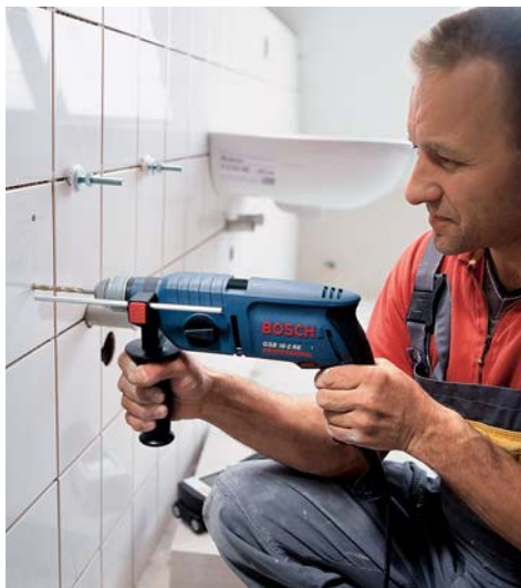
5.5. Использование ограничителя глубины при сверлении
