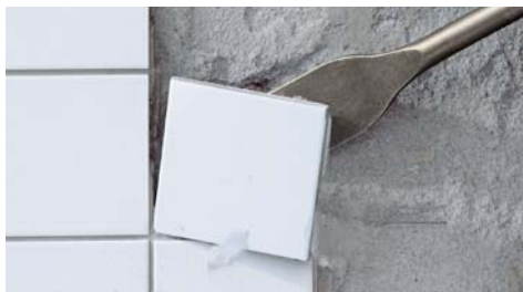
6.2. Использование перфоратора для снятия кафеля
