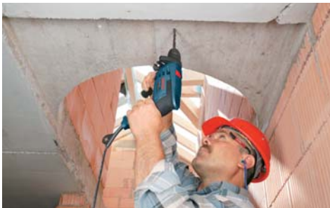
5.1. Использование ударной дрели для сверления в бетоне
