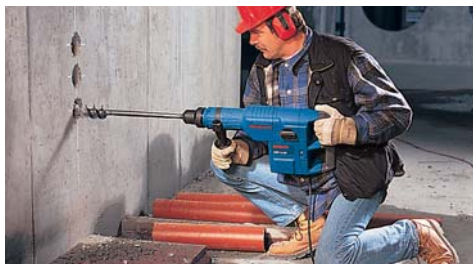
6.1. Использование перфоратора для сверления отверстий
