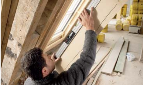
15.2. Определение угла наклона при помощи цифрового уклономера
