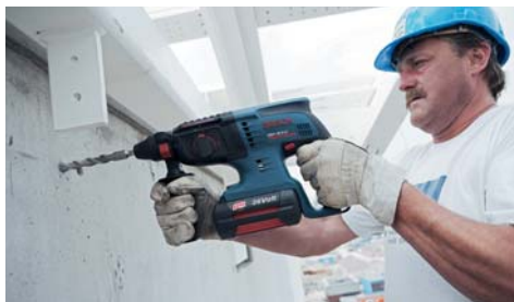
3.1. Использование аккумуляторного перфоратора при отсутствии доступа к электросети
